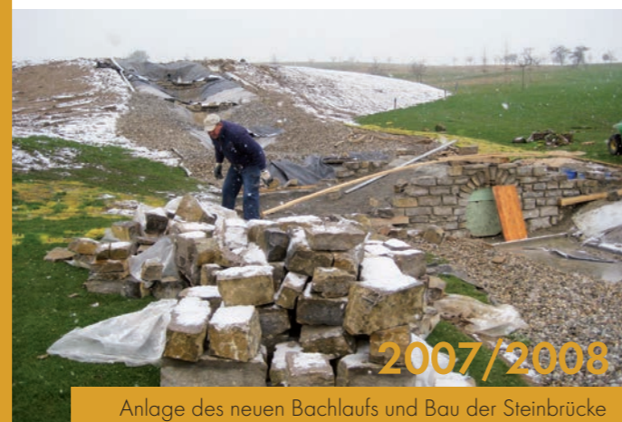
Anlage des neuen Bachlaufs
